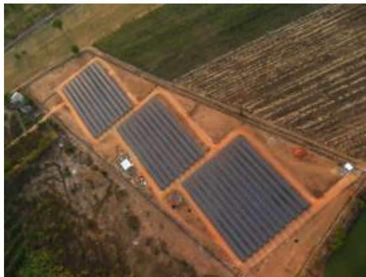
ภาพโรงไฟฟ้าพลังงานแสงอาทิตย์จากสถานที่จริงของ RSUN โครงการ 3
